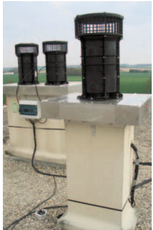
LE PROCÉDÉ UTILISE LES CONDUITS EXISTANTS DE LA VENTILATION NATURELLE. D'où la nécessité de vérifier, en premier lieu, leur tirage afin que l'extraction naturelle puisse prendre le relais de l'extracteur mécanique s'il s'avérait déficient. (Doc. Aereco.)
